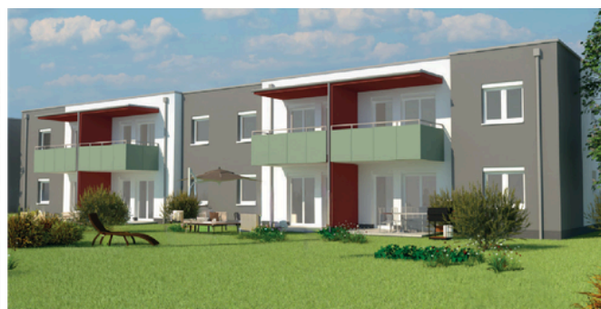
Weppersdorf Seniorenwohnungen in Bau
